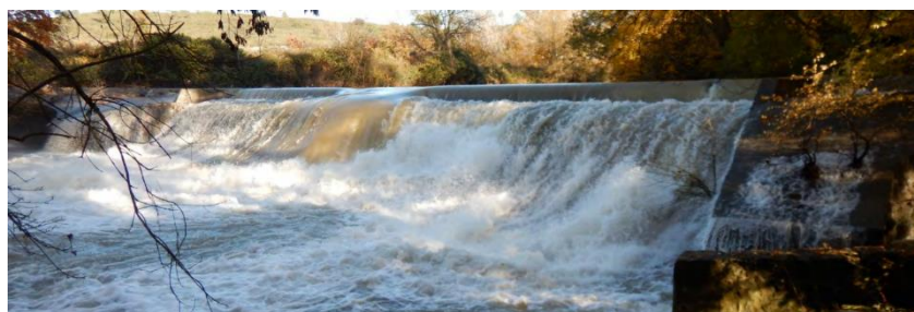
Seuil de Roquefavour sur l'Arc (source EPAZGE MENELIK)
